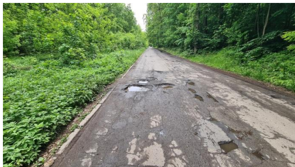
Przykład spękań w rejonie ul. Przemysłowej
