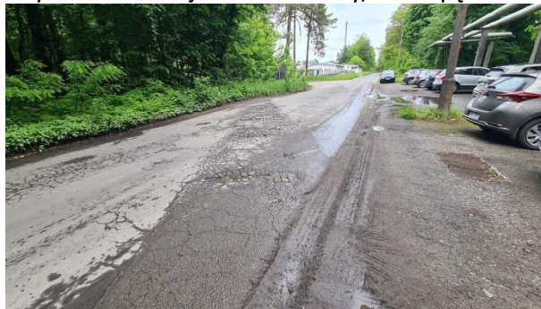
Przykład zniszczonej nawierzchni ulicy, liczne spękania
